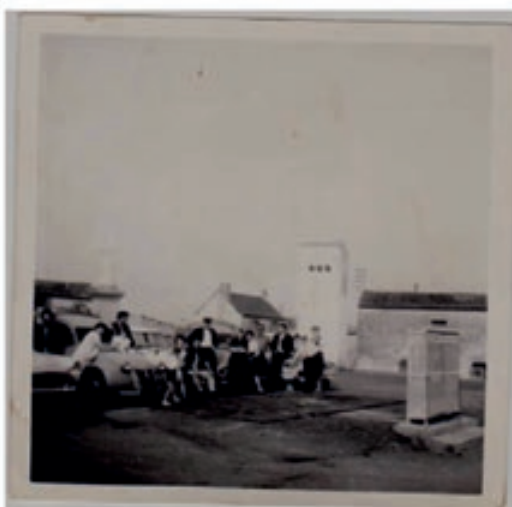
Photo prise en 1966 où l'on voit le Pont Basculer avec le tablier ( au sol) et l'armoire technique où se trouvait le système de pesage.
