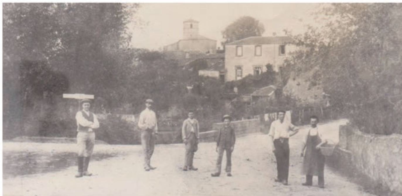
Vue prise du pont route de Beaurepaire
