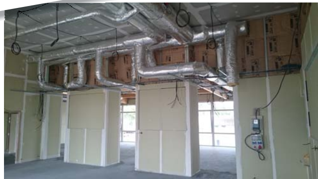
Salle de restauration Maternelle
