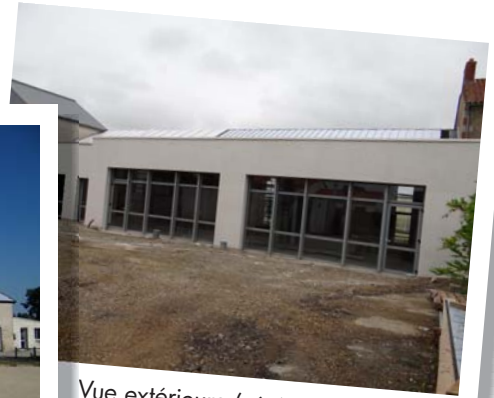
Vue extérieure (côté cour)
