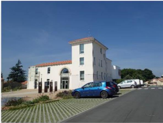
Exemple de stationnements enherbés, ce qui permet de réduire l'impact des zones imperméabilisées.
